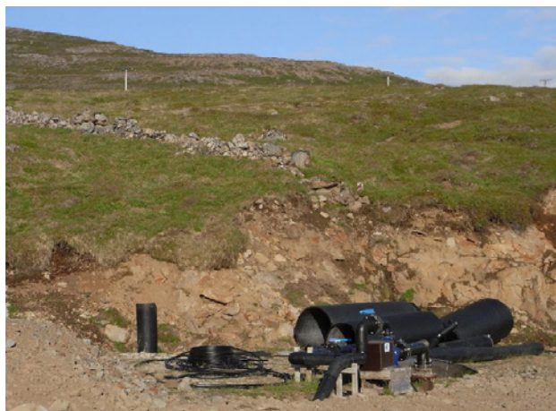
Mynd 4: Við suðvestur enda túngarðsins hefur svæðið verið lækkað og hluti túngarðsins horfið. (Mót suðaustri. Ljós. ÓLA).
