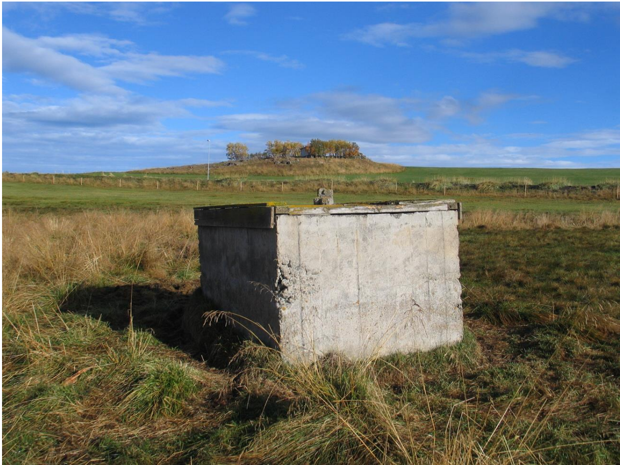
Mynd 238. Steypt er utan um brunninn [1728-455] sem áður var girtur af með trévirkki. Horft er til suðvesturs.
