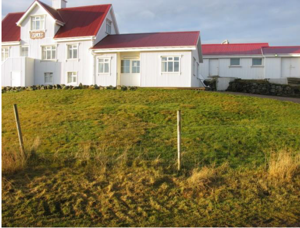
Mynd 9. Dældir í túninu framan við eldra íbúðarhúsið. Horft til vesturs.
