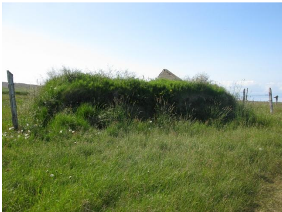
Mynd 33. Algróinn norðurveggur fjóssins.
