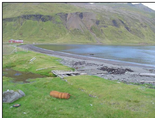
Vegur og brú 015, horft í norður
