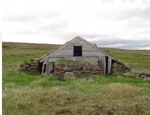
Hesthúsið, horft til austurs
