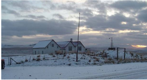
horft til VSV
