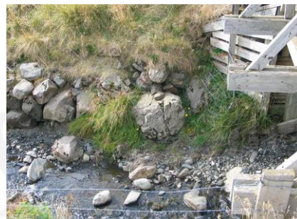
Leifar brúarstæðisins, horft til VNV
