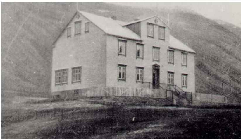
Mynd 26. Skólahúsið sem brann til grunna 1926, á sama stað var reist áhaldageymsla, hlaða og hesthús, sem er nú áhaldageymsla. Ljós. HSk.
