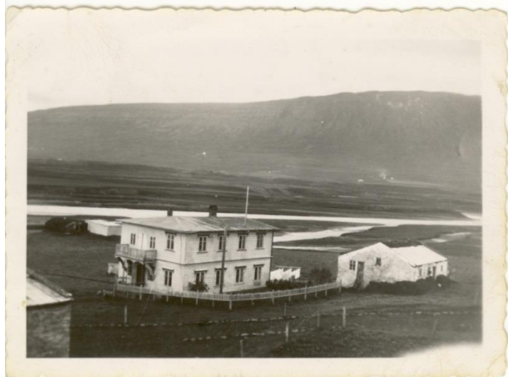
Mynd 9. Fjánhúsin sjást lengst til vinstri á mynd á bak við íbúðarhúsið og hvítahúsið hefur þá verið hesthús og hlaða sem byggð voru úr bárujárnri fyrir 4 hesta. Birt með leyfi Héraðsskjalasafns Skagfirðinga (öll afritun myndarinnar er óheimil).
