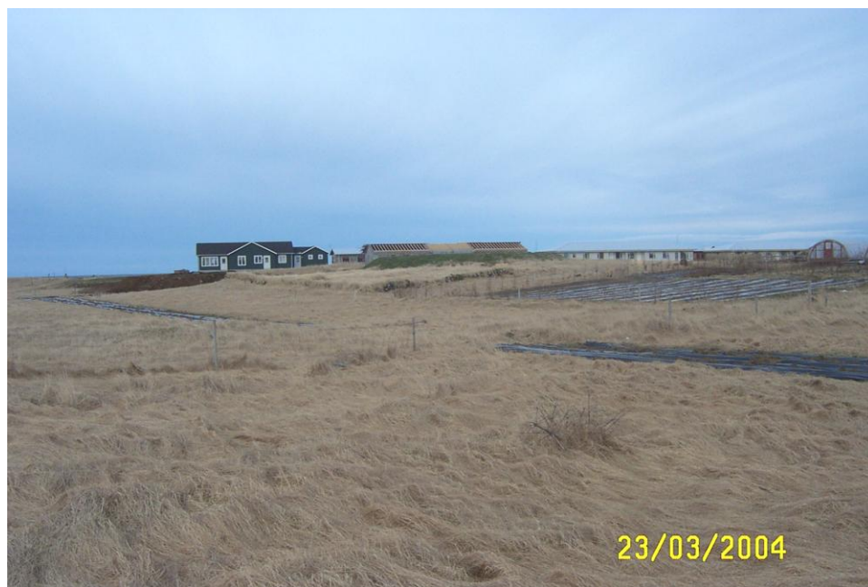
Mynd 5. B - 181050 55 –9 Horft í norður yfir bæjarstæði Bárugerðis og túngarð. Bárugerði ber í hús í byggingu. fyrir miðri mynd. Mynd Katrín Gunnarsdóttir.
